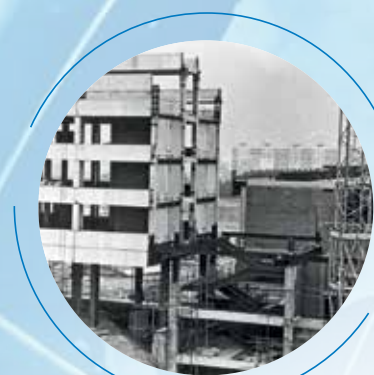
Строительство Главного корпуса на ул. Минлухо-Маклая
