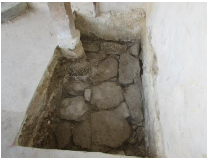
Рис. 6.38. Шурф 6. Фрагмент фундамента в осях К-МК/5
