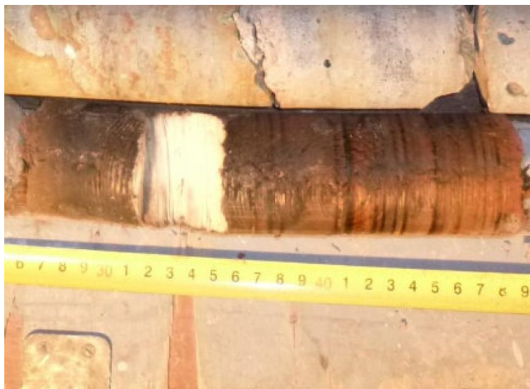
Рис. 6.11. Керны, отобранные из тела фундаментов Центральной башни здания Главного Адмиралтейства (строительство 1734 г.) (фото выполнено автором)
