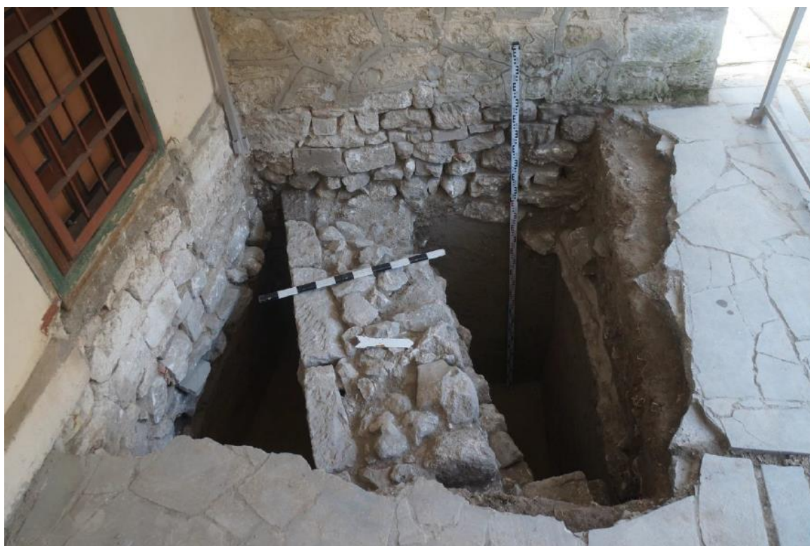
Рис. 6.34. Шурф 5. Фрагмент фундамента в осях Р/15
