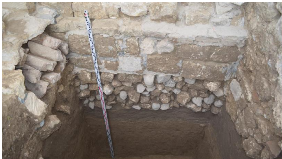
Рис. 6.31. Шурф 4. Фрагмент фундамента в осях П/2
