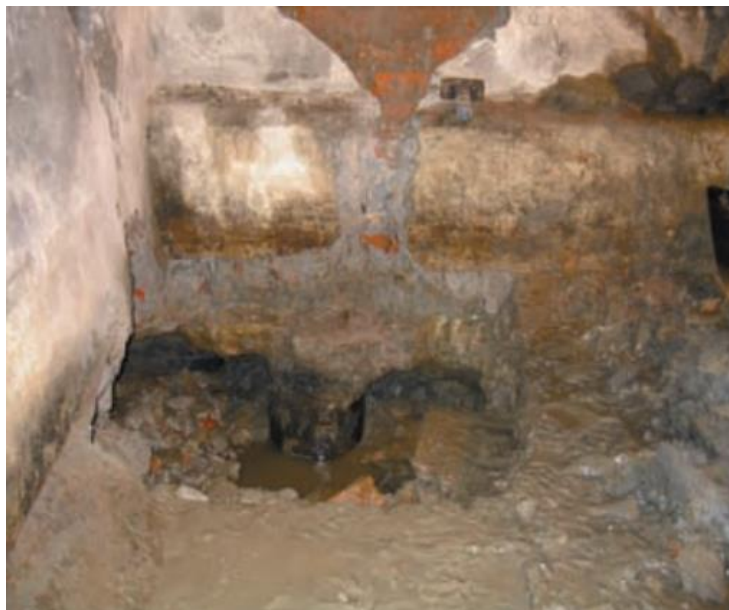
Рис. 6.13. Лежни и сваи под фундаментами здания по набережной р. Фонтанки, д. 7 (строительство 1832 г.; фото выполнено автором)
