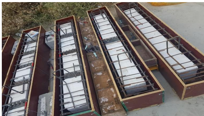
Рисунок 4 – Экспериментальные образцы до бетонирования
