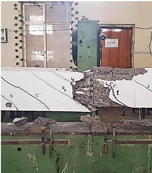
Разрушение защитного слоя бетона
