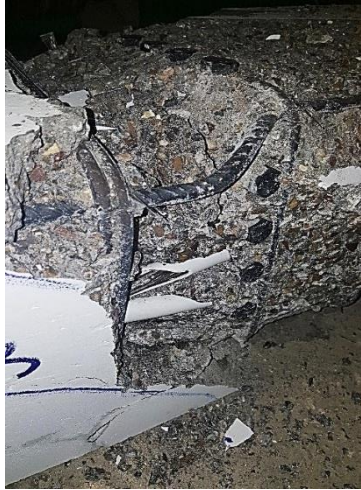
Выпучивание продольных стержней
