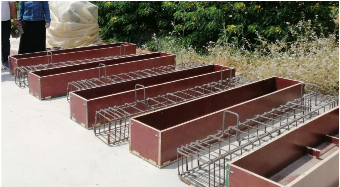
Рисунок 2-6 – Арматурные каркасы и опалубка
