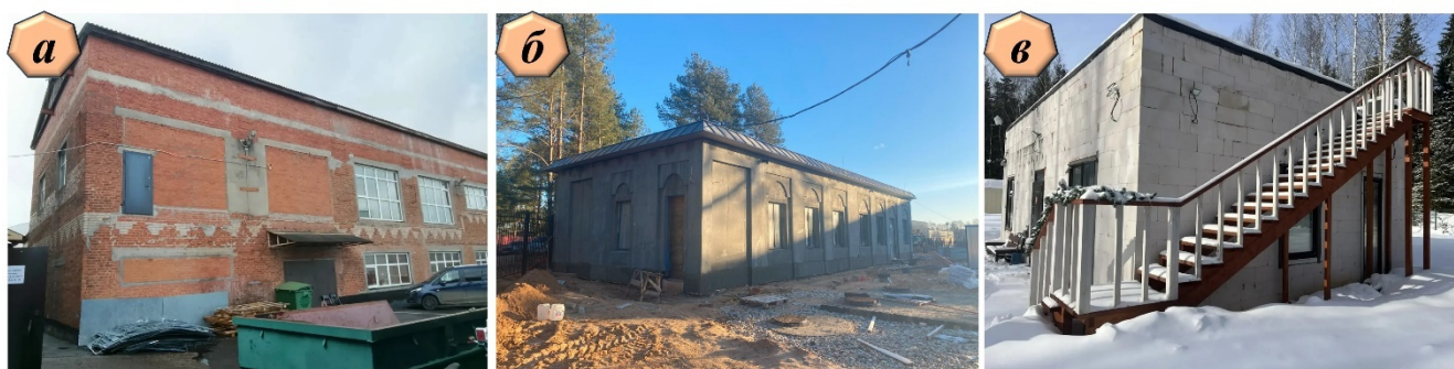
Рисунок 2.1. Примеры обследованных зданий (а – пилорама (город Подольск); б – контрольно-пропускной пункт (город Печоры); в – индивидуальный жилой дом (город Москва)).
