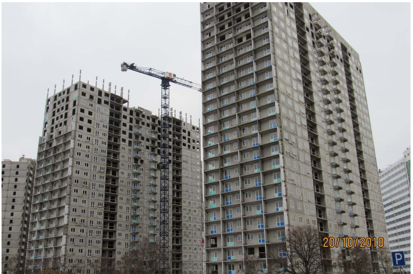
Рисунок 1.1 - Строительство жилого комплекса "Зеленоградский" (г. Москва)
