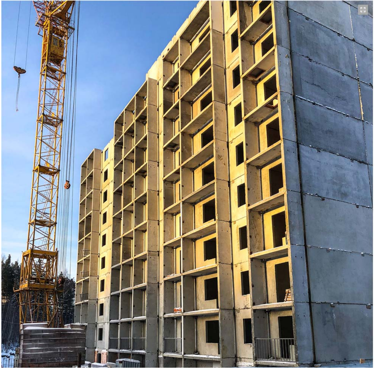
Рисунок 1.3 - Строительство многоквартирного жилого дома (г. Нягань)
