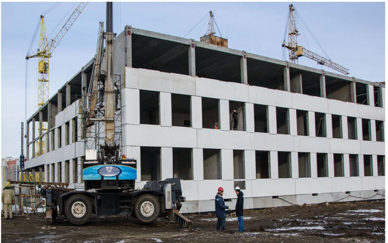
Рисунок 1.2 - Строительство школы "Ньютон" (г. Челябинск)
