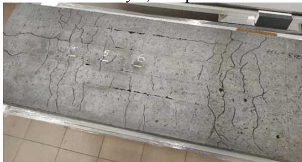
Рисунок 19. Результаты трещин плита типа 2
