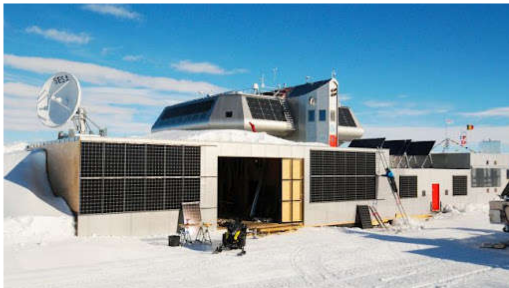
Рисунок 72. Конфигурация солнечных панелей на фасадах и прилегающей территории научной станции Princess Elisabeth. Фотография International Polar Foundation
