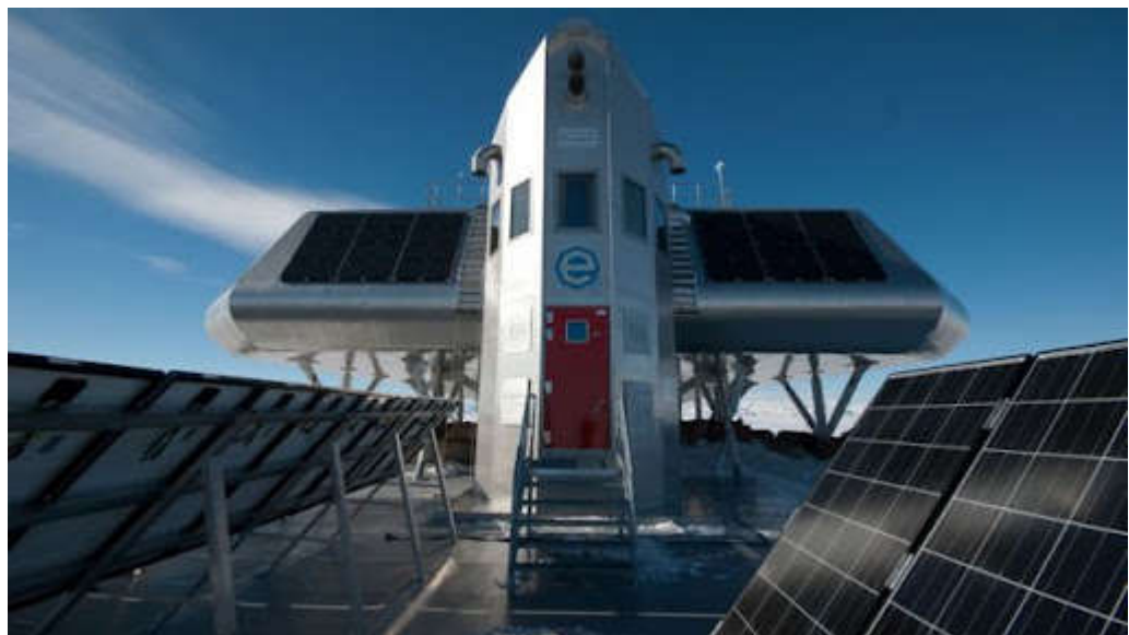
Рисунок 71. Конфигурация солнечных панелей на фасадах и прилегающей территории научной станции Princess Elisabeth. Фотография International Polar Foundation
