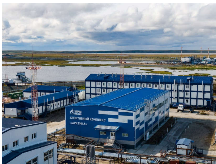
Рисунок 8. Проект вахтового поселка Новый Порт (Газпромнефть) на Ямале. Фотография «Газпромнефть».
