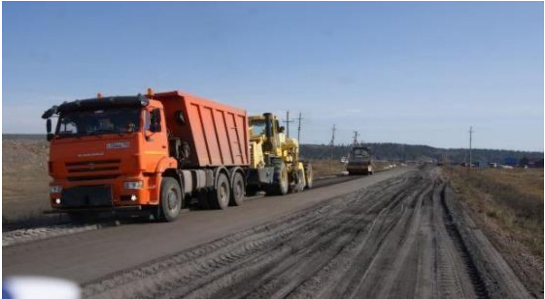
Рисунок 5.12 – Автомобильная дорога «Егоровщина – Рязановщина» Состав звена по устройству слоев укрепленных грунтов (фото автора)
