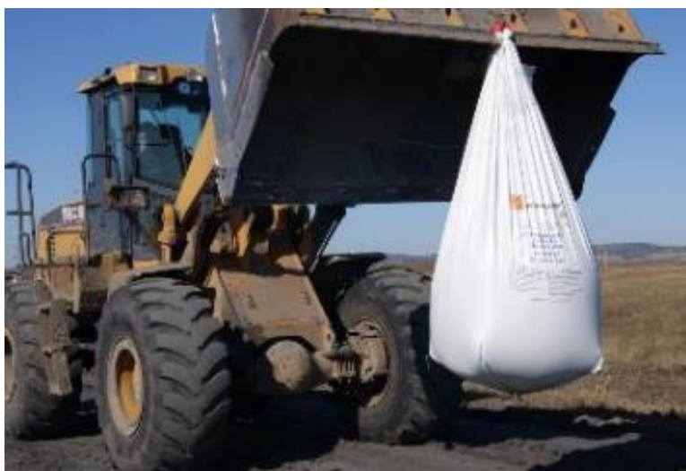
Рисунок 5.11 – Автомобильная дорога «Егоровщина – Рязановщина» Распределение портландцемента (фото автора)
