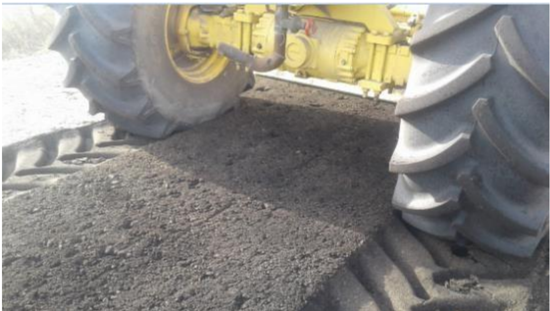
Рисунок 5.13 – Автомобильная дорога «Егоровщина – Рязановщина» Перемешивание грунта с портландцементом (фото автора)
