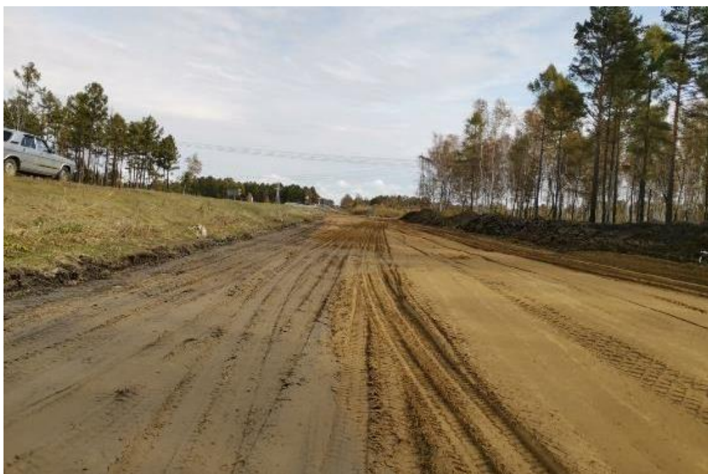
Рисунок 5.21 – Замена грунтов основания (фото автора)
