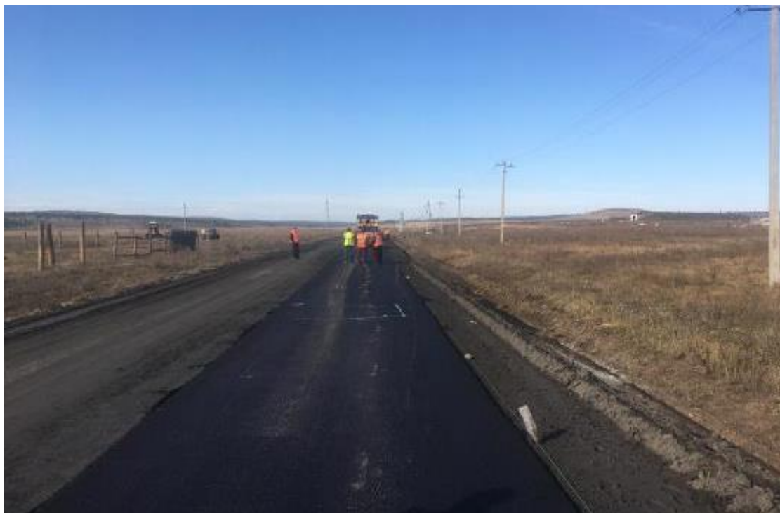
Рисунок 5.16 – Устройство покрытия из асфальтобетонной смеси Автомобильная дорога «Егоровщина – Рязановщина» (фото автора)
