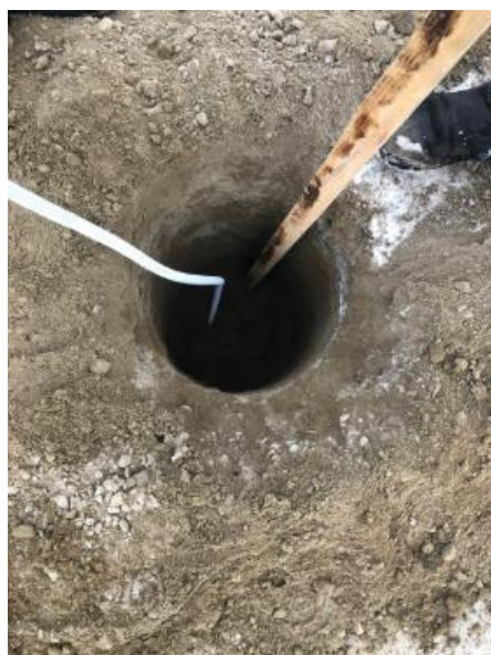
Рисунок 5.29 – Этапы установки датчиков контроля температуры и влажности (фото автора)
