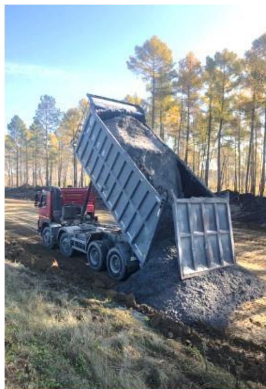
Рисунок 5.22 – Отсыпка слоев земляного полотна (фото автора)
