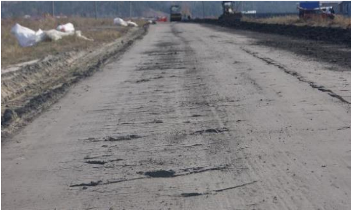
Рисунок 5.10 – Автомобильная дорога «Егоровщина – Рязановщина» Распределение и прикатка золошлаковой смеси (фото автора)
