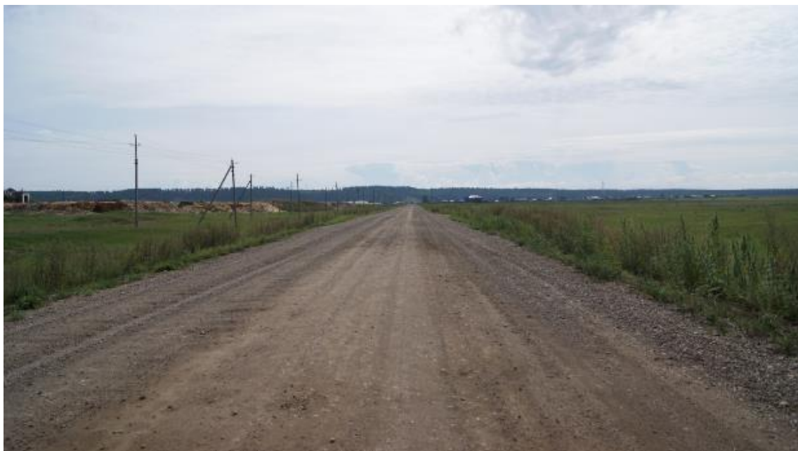
Рисунок 5.2 – Автомобильная дорога «Егоровщина – Рязановщина» Состояние до устройства опытно-экспериментальных конструкций дорожных одежд (фото автора)
