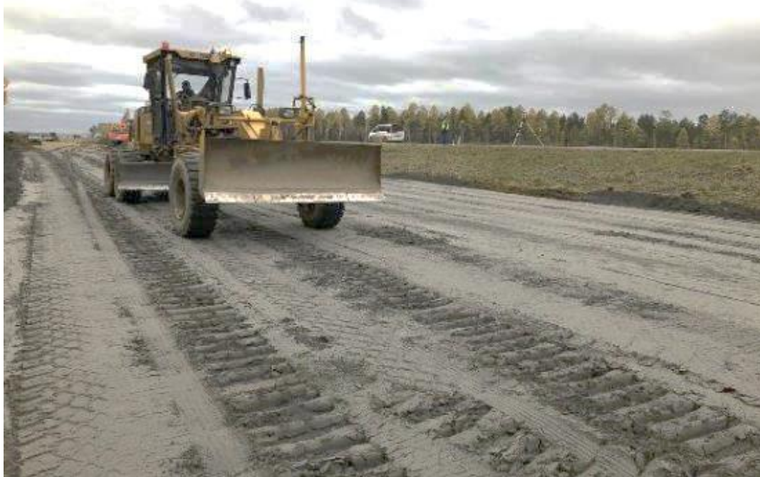
Рисунок 5.26 – Планировка слоев земляного полотна из золошлаковой смеси (фото автора)
