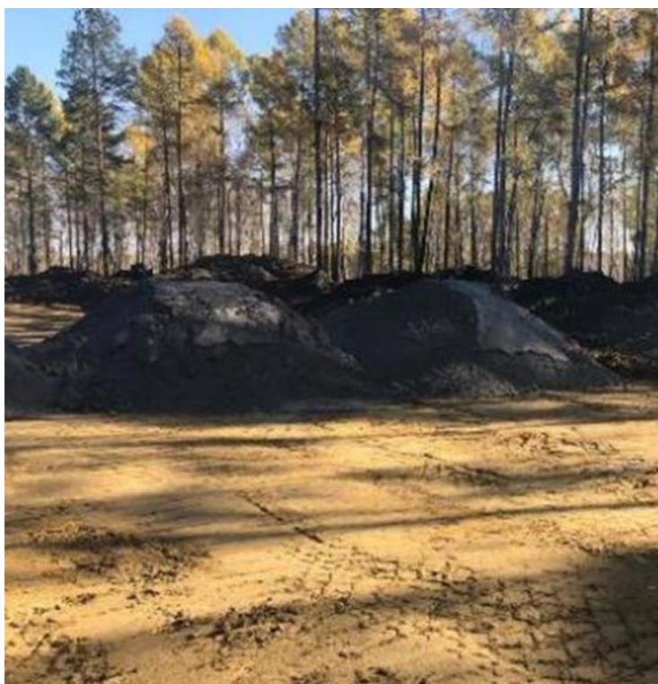
Рисунок 5.22 – Отсыпка слоев земляного полотна (фото автора)
