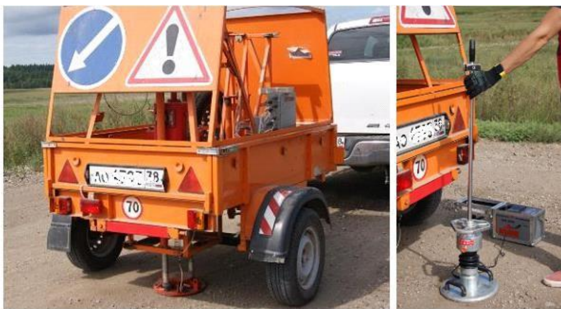
Рисунок 5.3 – Автомобильная дорога «Егоровщина – Рязановщина» Измерение модуля упругости до устройства опытно-экспериментальных конструкций дорожных одежд (фото автора)
