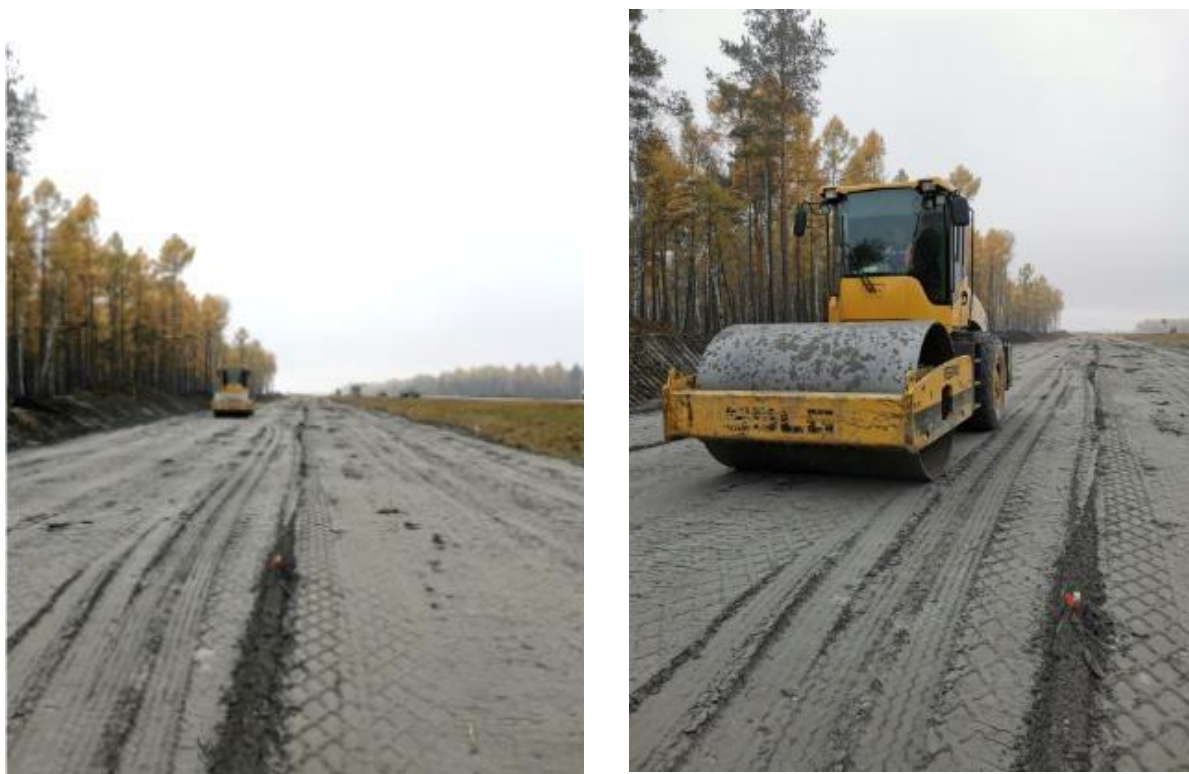
Рисунок 5.24 – Уплотнение слоев земляного полотна из золошлаковой смеси (фото автора)
