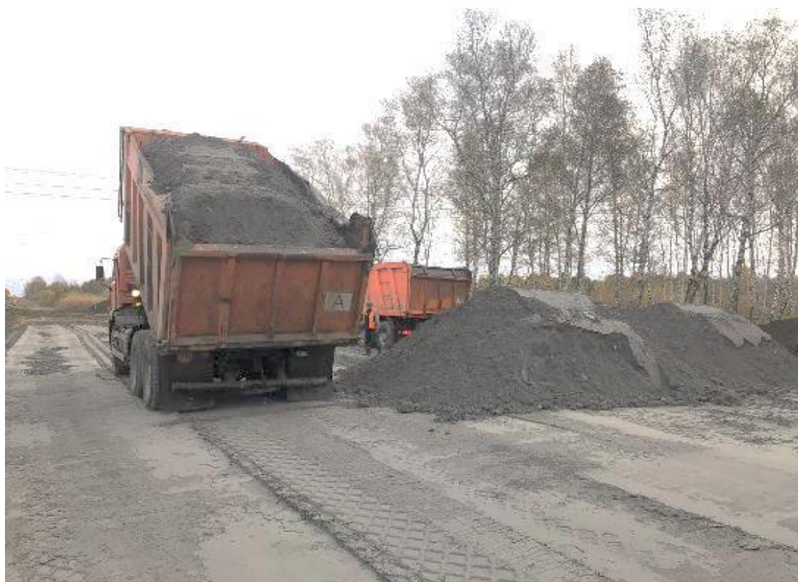
Рисунок 5.25 – Отсыпка последующих слоев земляного полотна из золошлаковой смеси (фото автора)
