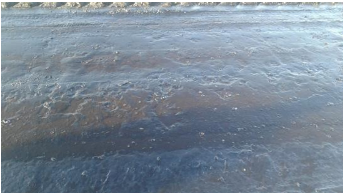
Рисунок 5.15 – Автомобильная дорога «Егоровщина – Рязановщина» Розлив вяжущих материалов (фото автора)
