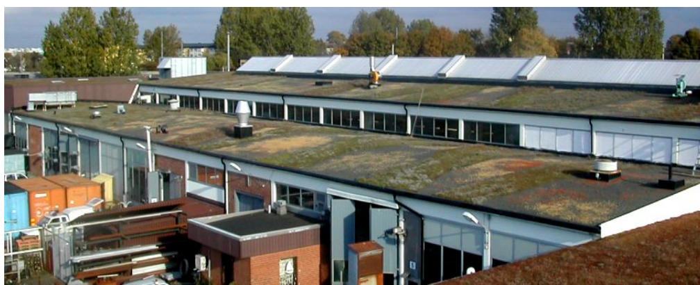
Рисунок 21 – Зелёные крыши и ливневки Augustenborg Botanical Roof Garden
