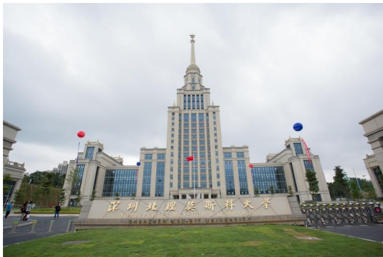
Рисунок 19. Главное здание МГУ-ППИ в китайском городе Шэньжэнь
