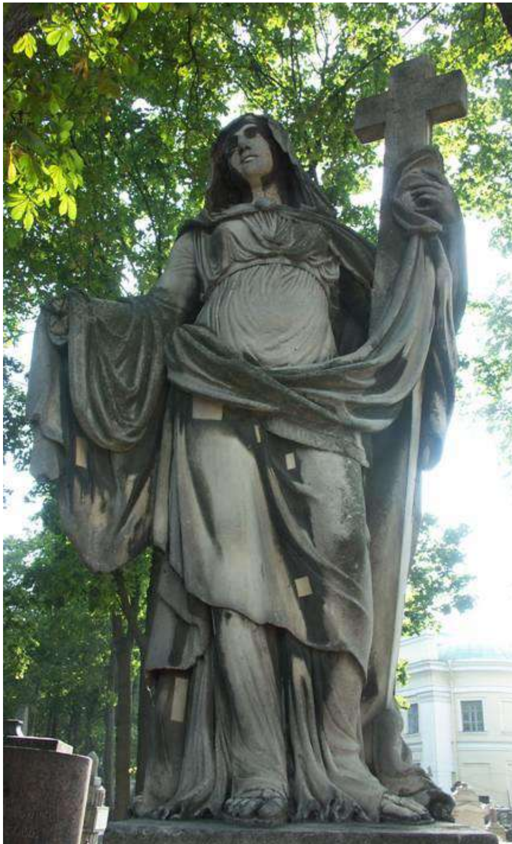
Рисунок 95 – Надгробие П.В. Киндякова (П. Катоцци, 1828 г., мрамор, гранит). Некрополь XVIII века ГМГС. Общий вид в процессе реставрации. Выполнены пробные расчистки черных корковых наслоений лазерным аппаратом Smart Clean II. Фото Ю.А. Логиновой. 2006 г.
