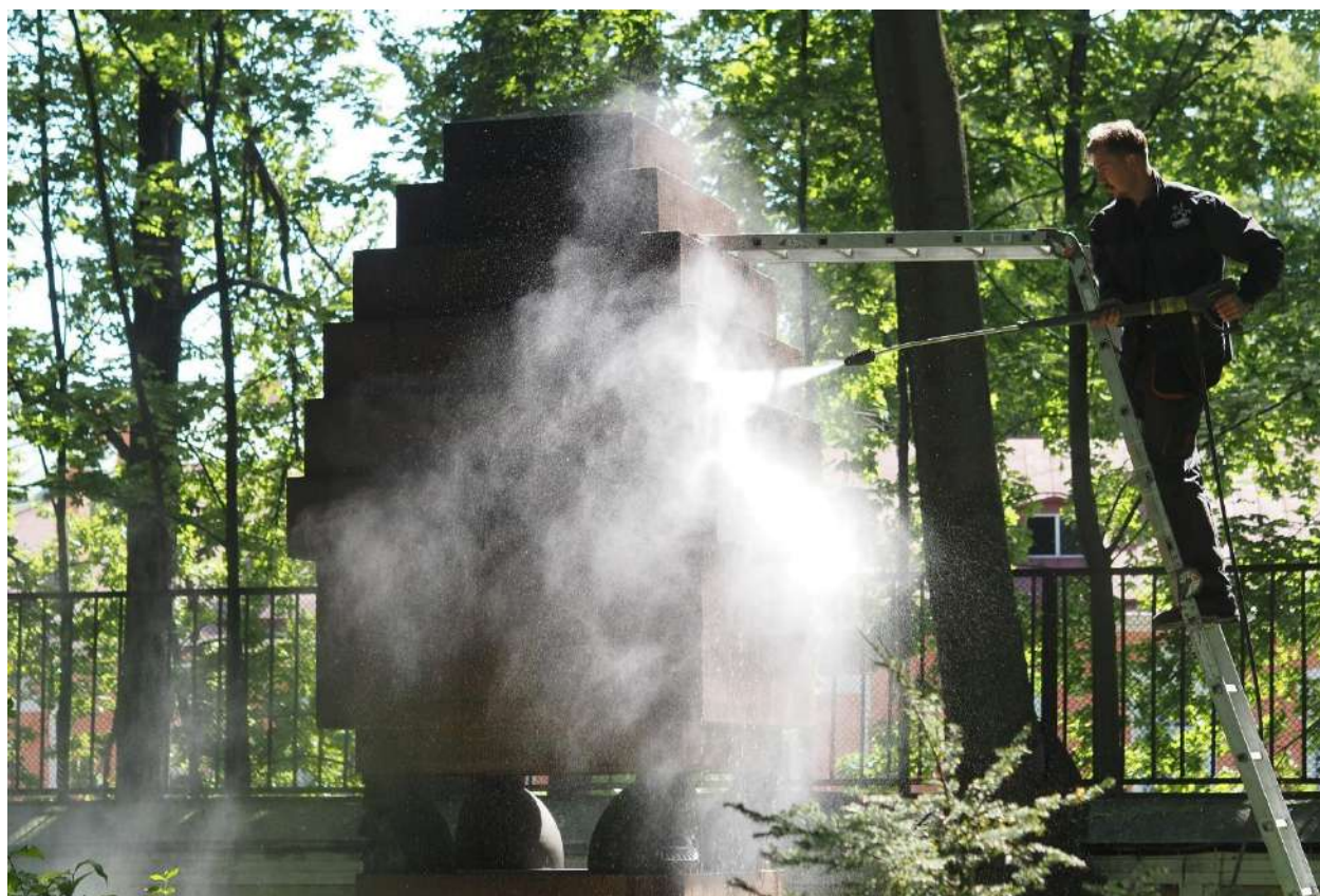
Рисунок 77 – Профилактический уход за художественными надгробиями Некрополя мастеров искусств. Промывка поверхности камня. 2022 г. Архив ГМГС
