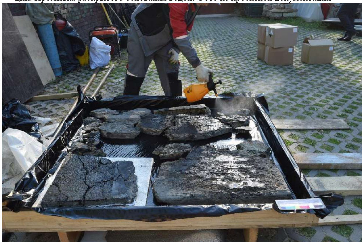
Рисунок 128 – Надгробие «Мавзолей-пирамида П.Н. Щербатова» в процессе реставрации. Структурное укрепление методом пропитки мемориальной плиты. Фото из проектной документации
