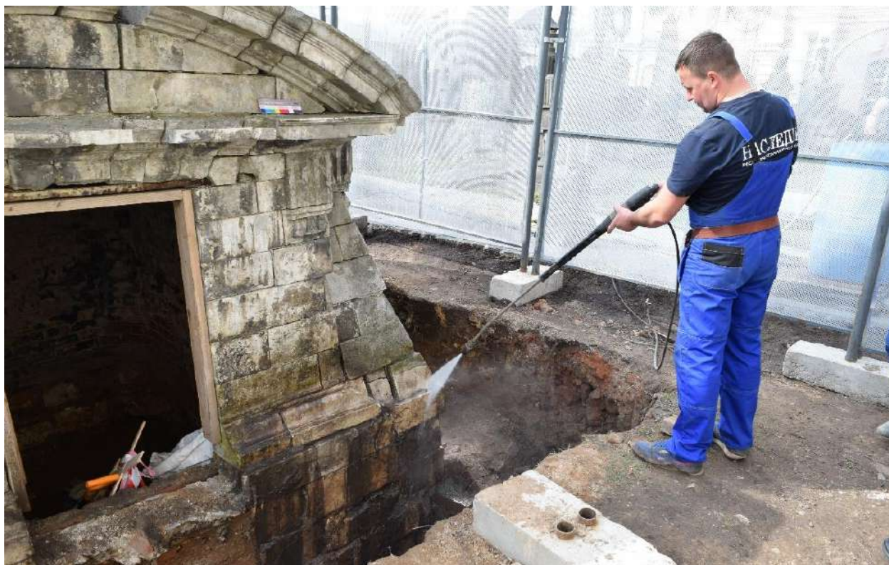
Рисунок 127 – Надгробие «Мавзолей-пирамида П.Н. Щербатова» в процессе реставрации. Промывка раскрытого основания водой. Фото из проектной документации
