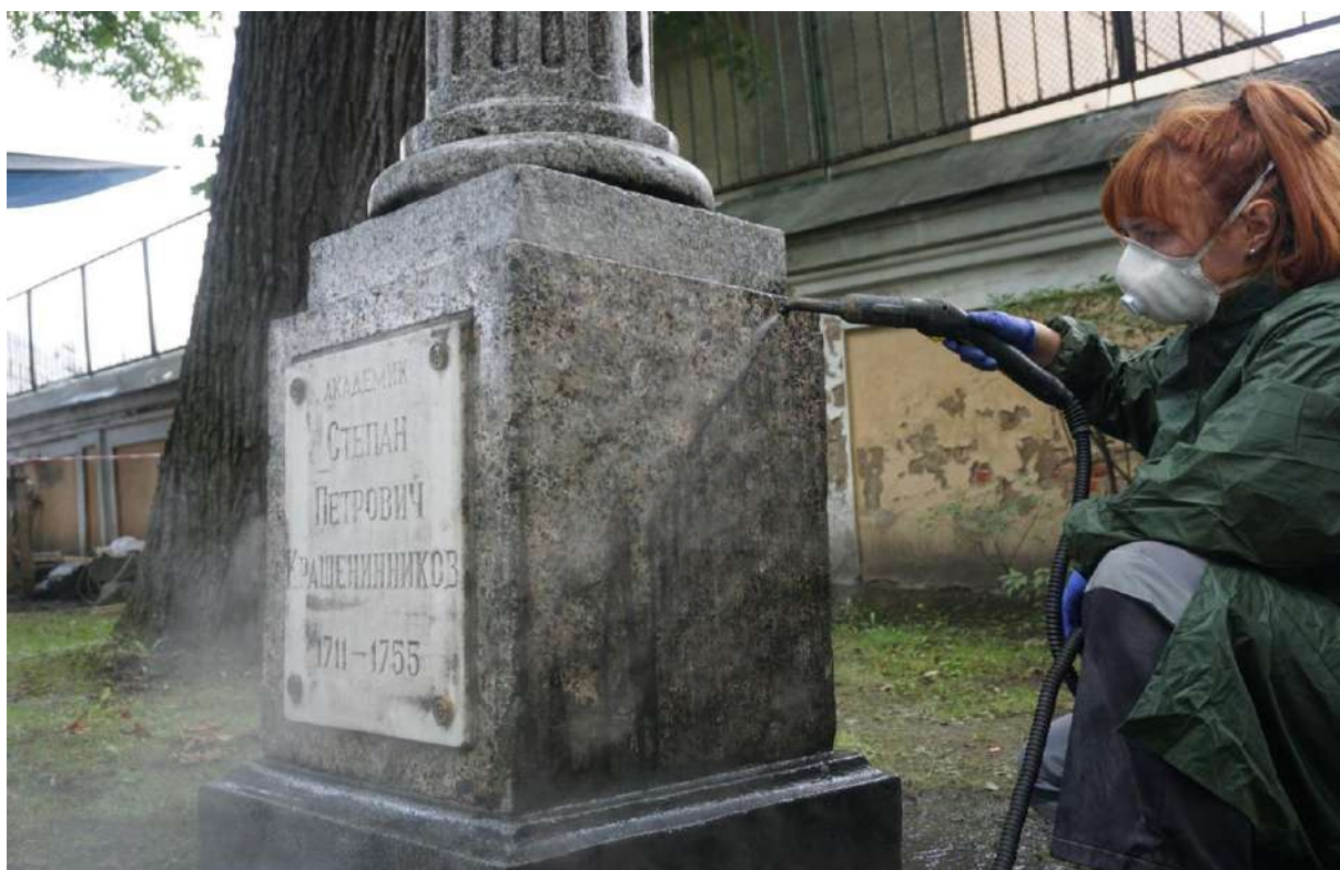
Рисунок 72 – Профилактический уход. Расчистка поверхности мрамора горячим паром. 2018 г.
