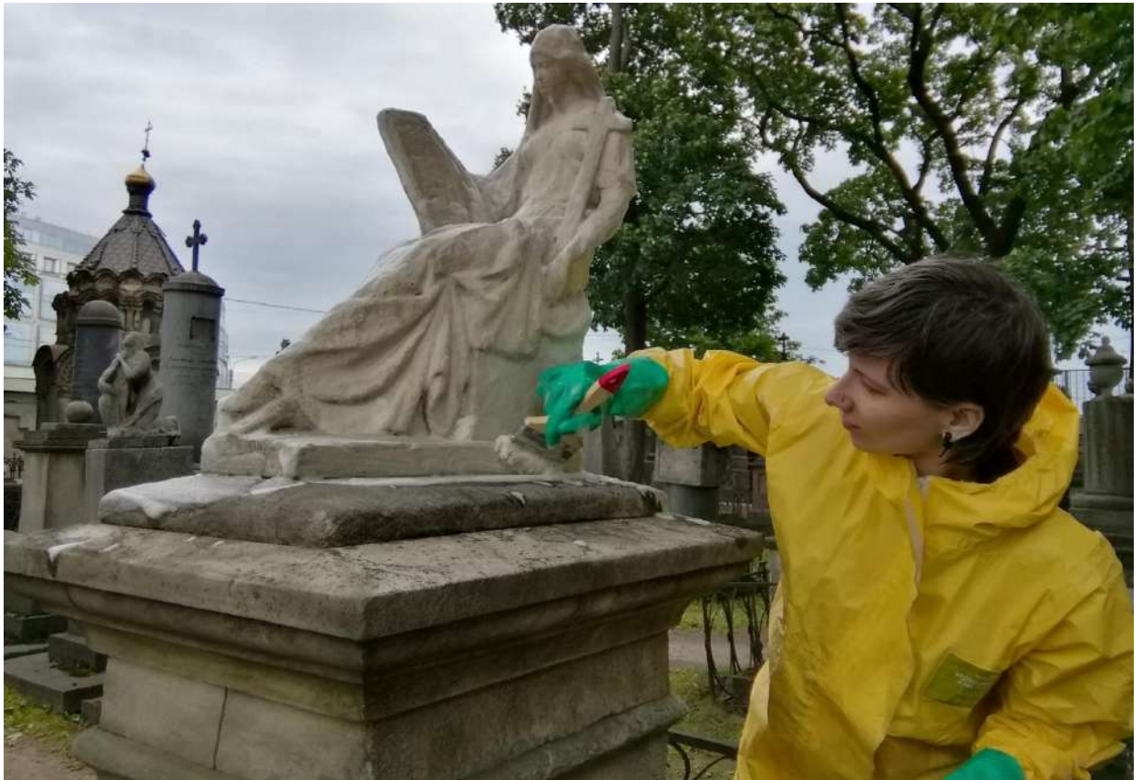
Рисунок 74 – Профилактический уход за художественными надгробиями Некрополя XVIII века. Промывка поверхности камня. 2019 г.
