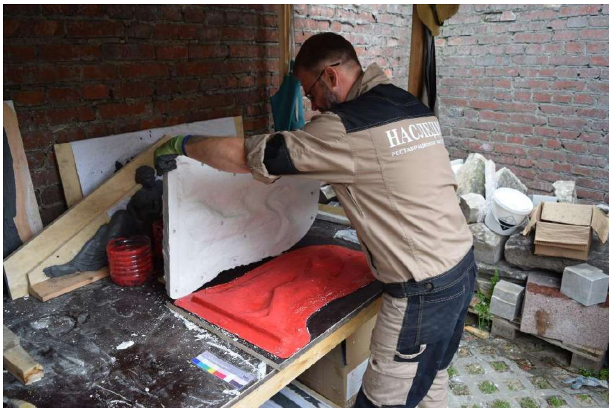
Рисунок 125 – Захоронение Маслова Александра Семеновича. В процессе реставрационных работ. Изготовление утраченного барельефа, снятие силиконовой формы, отливка модели в гипсе и фактуровка
