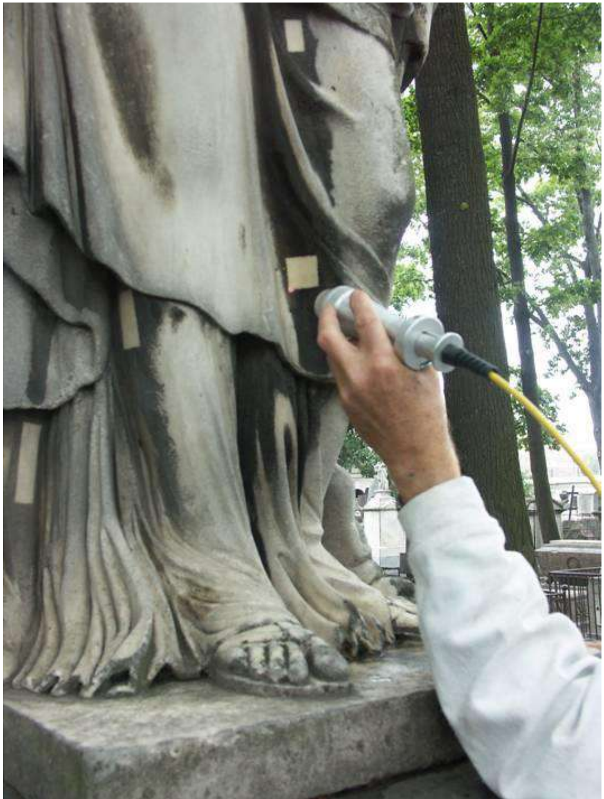
Рисунок 96 – Фрагмент надгробия П.В. Киндякова. В процессе реставрации. Процесс расчистки поверхности от черных корковых наслоений лазерным аппаратом Smart Clean II. Фото Ю.А. Логиновой. 2006 г.
