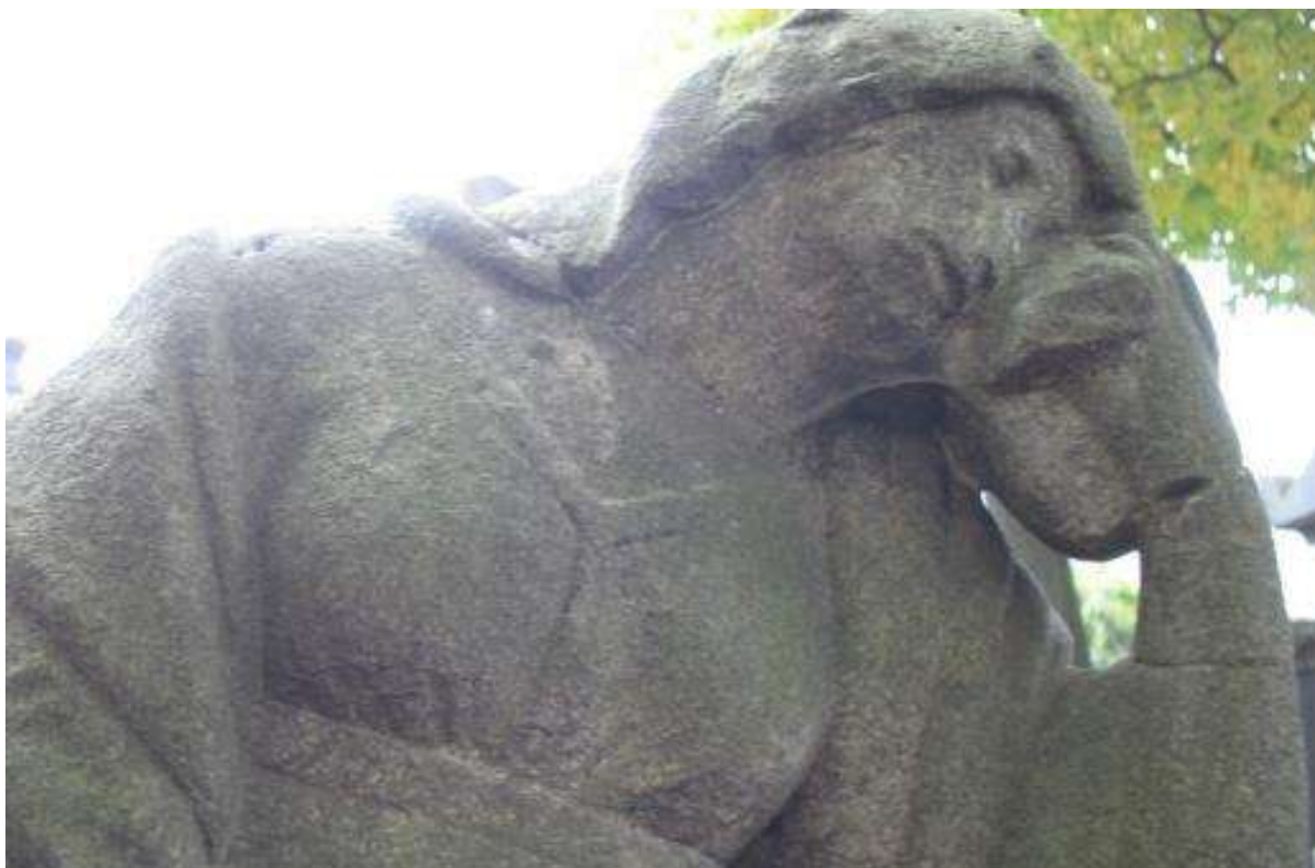
Рисунок 5 – Надгробный памятник Олениной В.М. в Некрополе XVIII века Александро-Невской лавры (фрагмент). Биопленка на поверхности мрамора статуи, состоящая из колоний темноокрашенных грибов, слоевищ лишайников и налета водорослей
