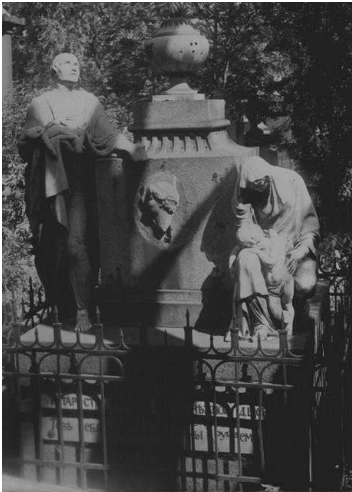
Рисунок 15 – Надгробие С.А. Строгановой (скульптор М.И. Козловский, 1802 г., мрамор, гранит). Общий вид. 1941 г. Разрушение мраморных статуй и барельефа в результате процессов выветривания. Архив ГМГС. Фото №1451. Нег. № 998
