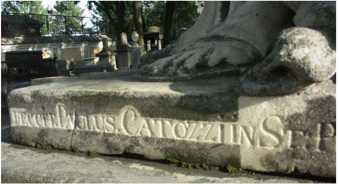
Рисунок 98 – Фрагмент надгробия П.В. Киндякова. Вид в процессе реставрации. Выполнены пробные расчистки авторской подписи на плинте скульптуры от бионаслоений лазерным аппаратом Smart Clean II 2006 г. Фото Ю.А. Логиновой. 2006 г.
