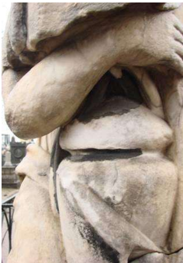
Рисунок 105 – Корковый вид разрушения мраморной скульптуры. Стадия отслаивания чёрной корки вместе с нижележащим разрушенным мрамором
