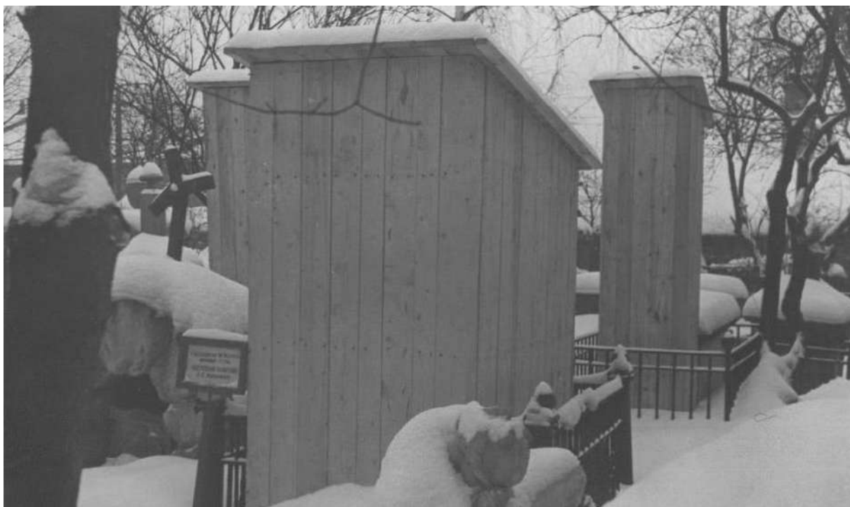
Рисунок 63 – Укрытие памятников Некрополя XVIII века деревянными футлярами. 1949 г. Архив ГМГС. Фото № 793/3
