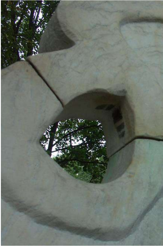
Рисунок 88 – Надгробие Н.А. и Н.Н. Римских-Корсаковых, фрагмент. В процессе реставрации. В углублениях имеются черные корковые наслоения. Фото Ю.А. Логиновой. 2006 г.
