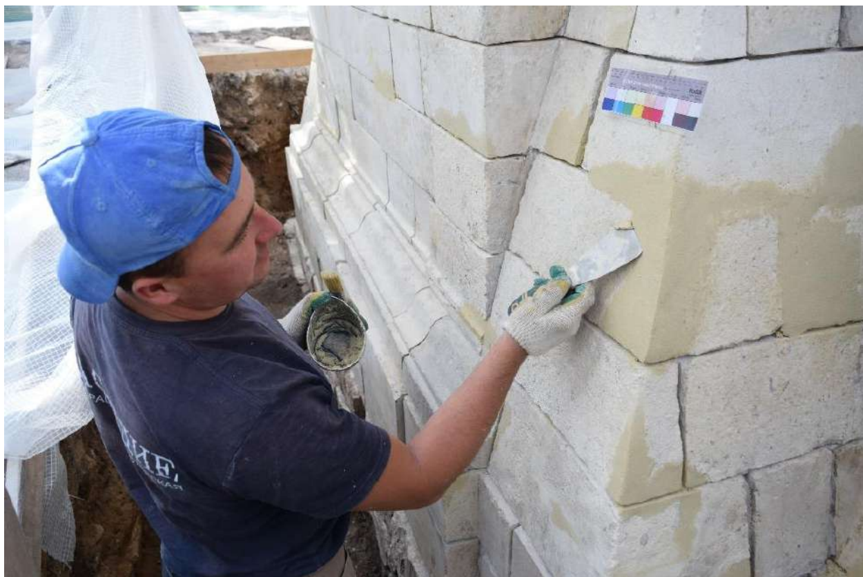
Рисунок 129 – Надгробие «Мавзолей-пирамида П.Н. Щербатова» в процессе реставрации. Восполнение утрат. Фото из проектной документации
