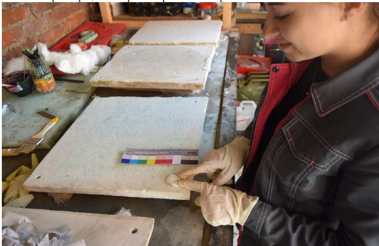
Рисунок 124 – Семейное захоронение Глебовых-Стрешневых. В процессе реставрационных работ. Химическая расчистка от пятен краски, ржавчины поверхности памятника из камня
