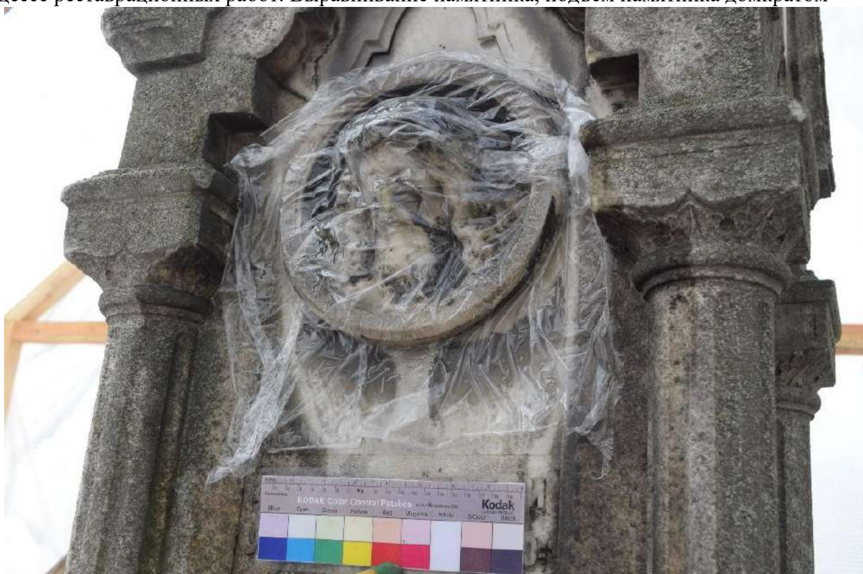
Рисунок 122 – Захоронение Батюшковой Татьяны Алексеевны (1827–1885 гг.). В процессе реставрационных работ. Структурное укрепление камня
