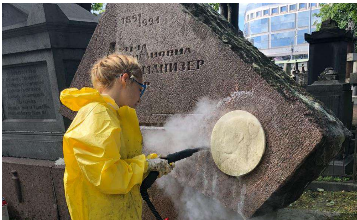
Рисунок 69 – Профилактический уход за художественными надгробиями Некрополя XVIII века. Расчистка поверхности мрамора горячим паром. 2019 г.
