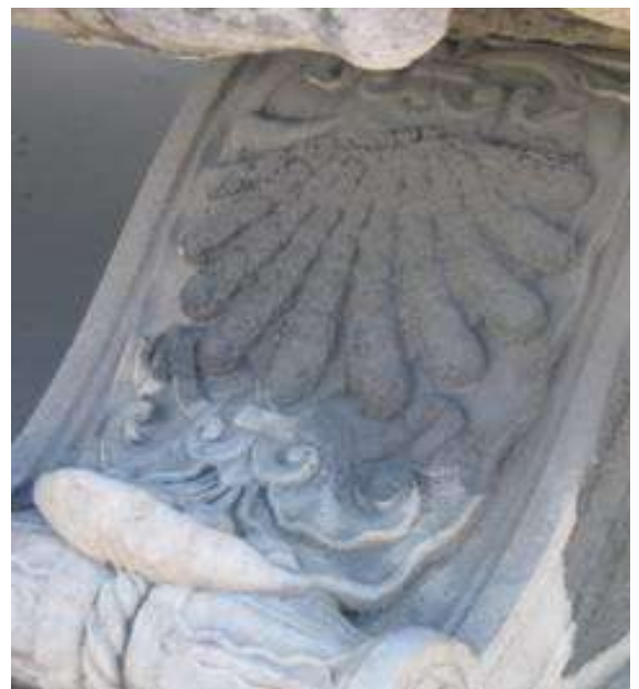
Рисунок 104 – Корковый вид разрушения мраморной скульптуры. Стадия формирования плотной гроздевидной корки
