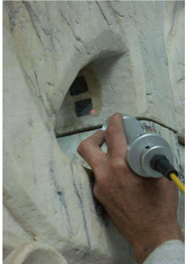
Рисунок 89 – То же (см. рис. 88), в процессе реставрации. В процессе расчистки мрамора от черных корковых наслоений лазерным аппаратом Smart Clean II. Фото Ю.А. Логиновой. 2006 г.
