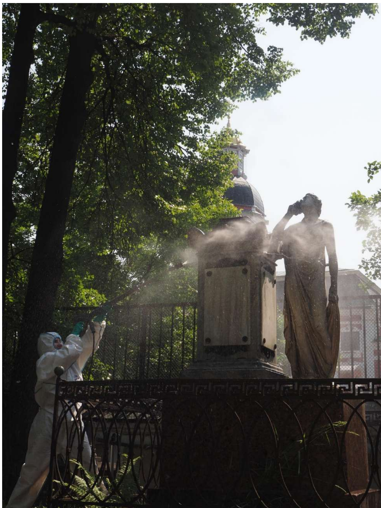
Рисунок 78 – Профилактический уход за художественными надгробиями Некрополя XVIII века. Промывка поверхности камня. 2022 г. Архив ГМГС
