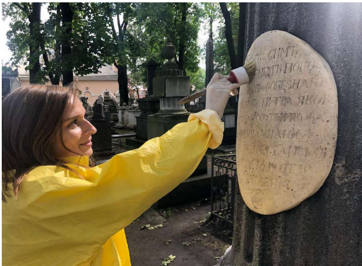
Рисунок 68 – Профилактический уход за художественными надгробиями Некрополя XVIII века. Проведение биоцидной обработки мраморного медальона. 2018 г.
