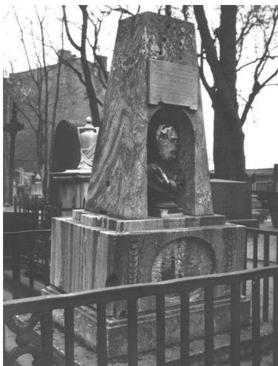
Рисунок 29 – Надгробие А.В. Мещерского (ск. Я. Земельгак, 1782 г., мрамор, гранит, известняк, чугун). Общий вид. 1952 г. Аварийное состояние мраморного бюста. Деструкция и отслаивание участков мрамора. Архив ГМГС. Фото № 5306/1
