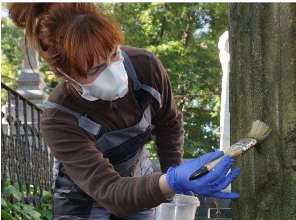
Рисунок 73 – Профилактический уход за художественными надгробиями Некрополя XVIII века. Проведение бицидной обработки камня. 2018 г.
