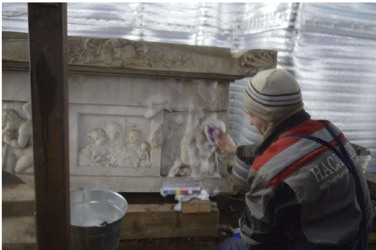
Рисунок 123 – Захоронение Тутолмина Ивана Васильевича (1760–1839 гг.). В процессе реставрационных работ. Промывка поверхности камня с ПАВ
