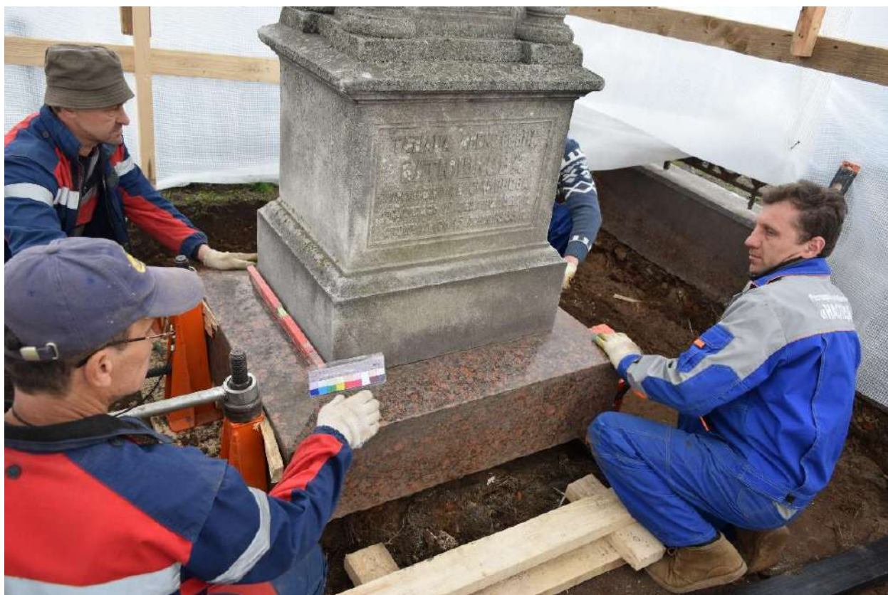
Рисунок 121 – Захоронение Батюшковой Татьяны Алексеевны (1827–1885 гг.). В процессе реставрационных работ. Выравнивание памятника, подъем памятника домкратом
