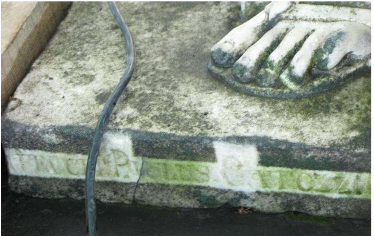
Рисунок 99 – То же (см. рис. 98), в процессе реставрации. Через год после расчистки лазерным аппаратом выявлено биообрастание мрамора. Фото Ю.А. Логиновой. 2007 г.
