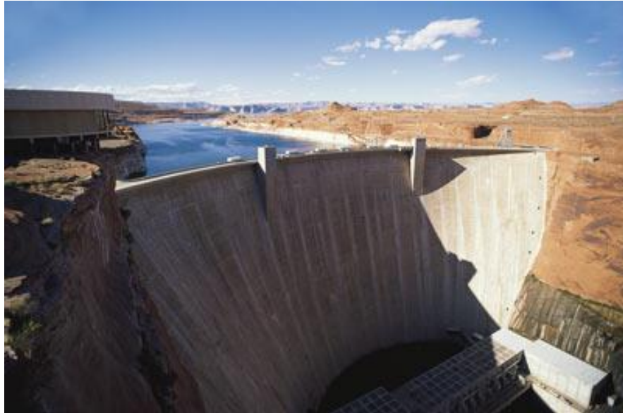
Рисунок 1.19. Общий вид плотины «Карбония» [59]
