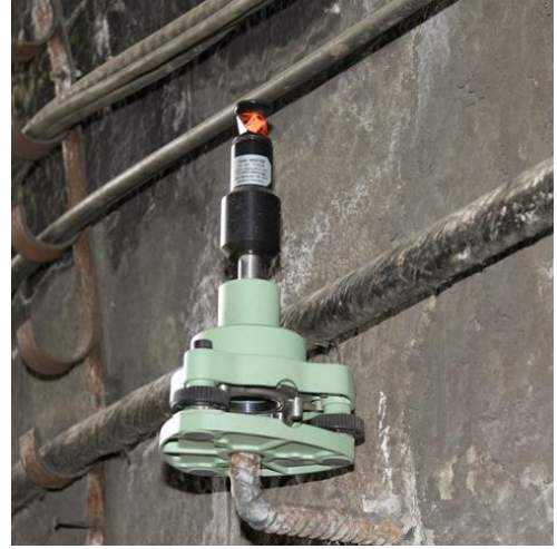
Рисунок 1.18. Призма опорной сети, расположенная вне зоны деформаций
