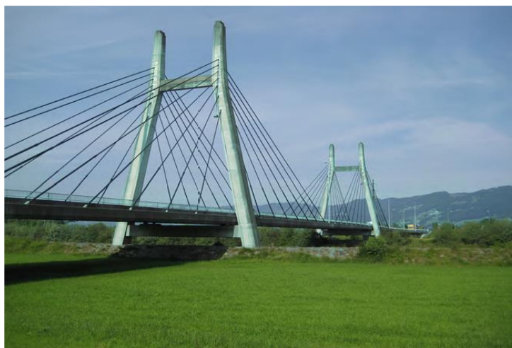
Рисунок 1.20. Общий вид вантового моста через р. Рейн
