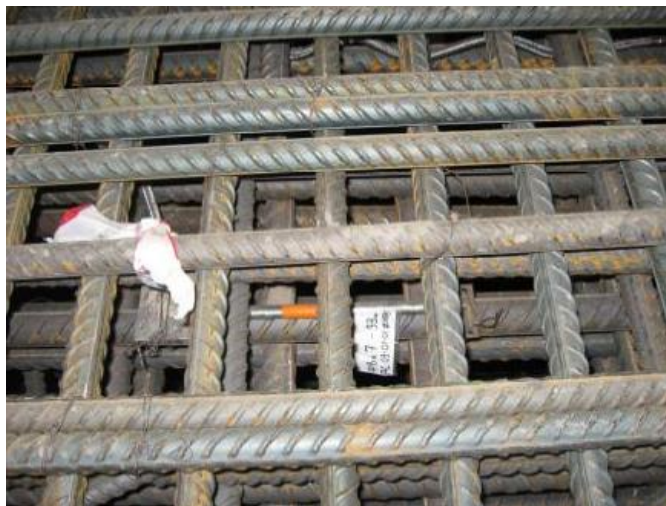
Рисунок 1.10. Датчик деформаций, установленный на арматурных стержнях конструкций фундамента высотного здания [48]
